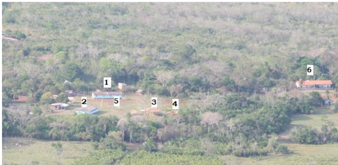
Figura 27 – Centro da vila do Ererê: (1) Capela; (2) barracão de festa; (3) prédio da APRORE; (4) Fábrica de polpa; (5) área recreativa; (6) escola do Ererê, 16 Mai. 2013
