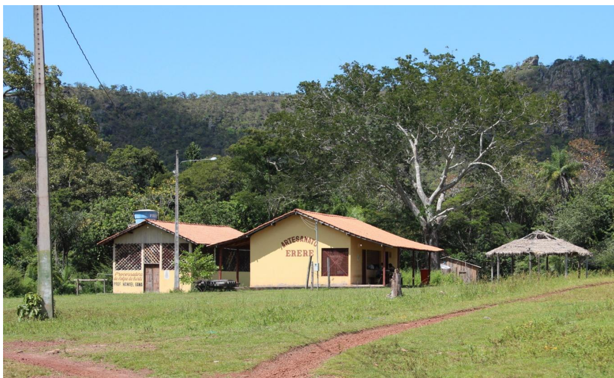
Figura 28 - Prédios destinado à fabricação de artesanato e beneficiamento da polpa do miriti no Ererê
